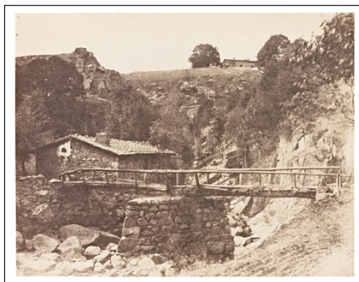
Atelier d'émoulage sur la Durolle dans la "Vallée des rouets", Thiers, Puy de Dôme, vers 1855
